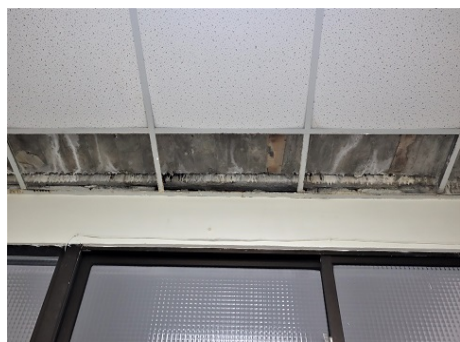
1. 土木系測量館 建築伸縮縫
